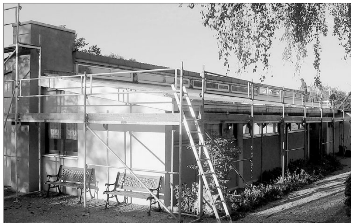
Mit den Sanierungsarbeiten am Mehrstetter Kindergarten haben die Arbeiter jetzt begonnen. Foto: Privat
